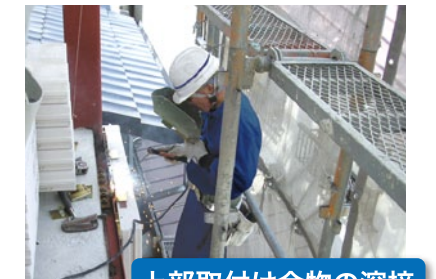
上部取付け金物の溶接
