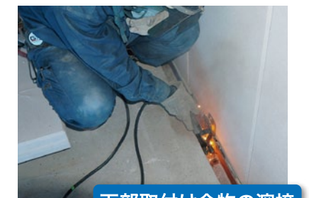
下部取付け金物の溶接
