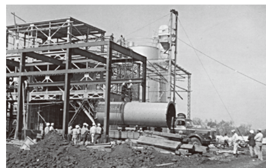
ALC工場の建設
