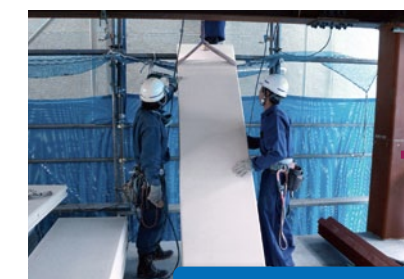
パネルの建込み
